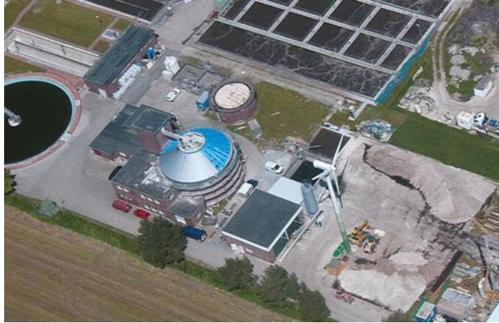
Faulbehälter der KA Aurich-Haxtum
